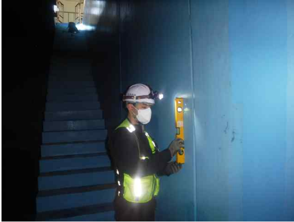
〔배수지 내부 : 기울기측정 전경〕
