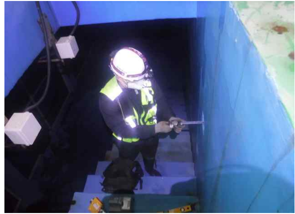
(콘크리트 탄산화 깊이 측정)
