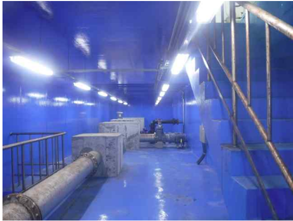
〔유입밸브실 내부 전경〕
