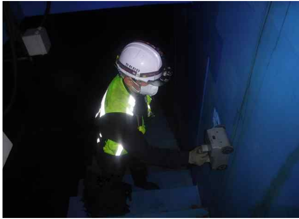
(콘크리트 피복두께 측정)
